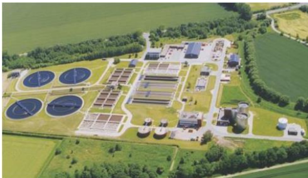
Очистное сооружение в Вильгельмсгафене/Германия
