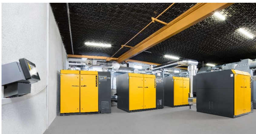
показательная станция: Очистные сооружения „Bietigheim-Bissingen“
