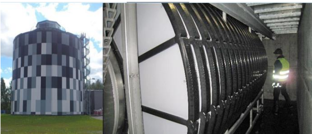
Kläranlage Tartu /Estland
